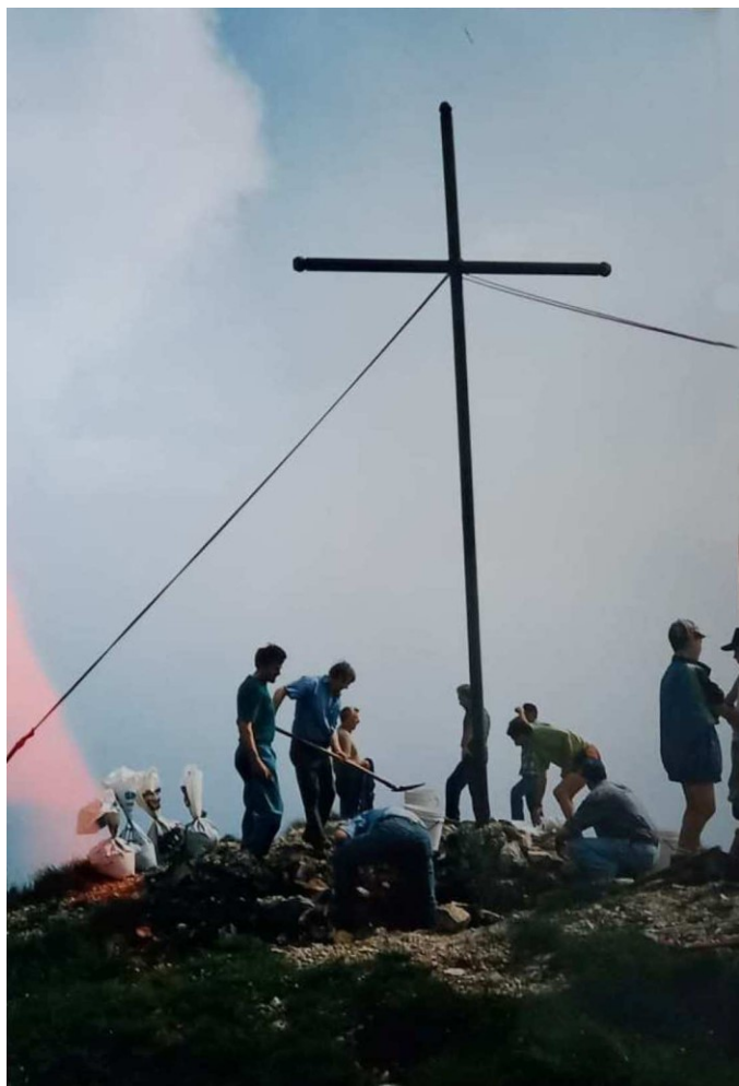
1997: Lavori di risanamento.
